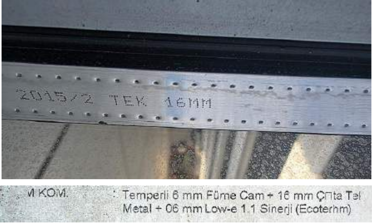
Resim 21. 16mm Hava Boşluklu Alüminyum Doğramalı Pencere ve Etiket
