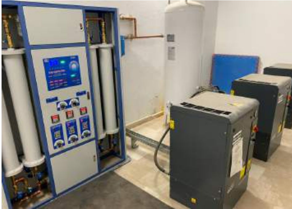
Resim 60. Basıncılı Hava Kompresörü
