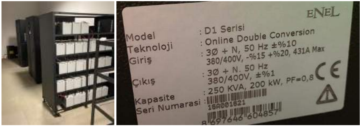
Resim 52. UPS Sistemi ve Etiketi
