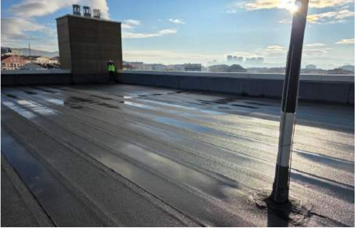
Resim 14. Binaya Ait Düz Çatı
