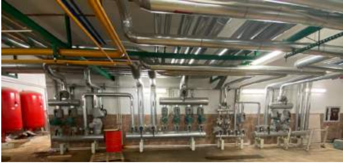
Resim 50. Yalıtımlı ve Yalıtımsız Tesisat Elemanları
