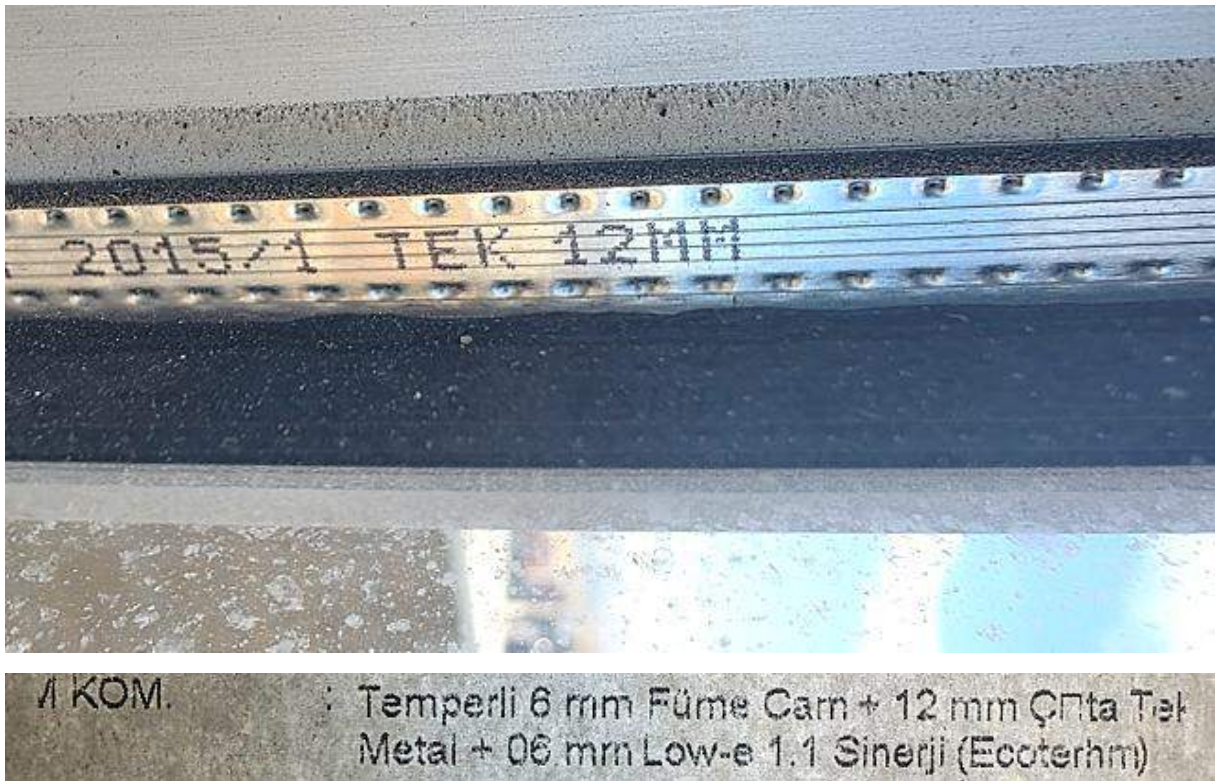
Resim 22. 12mm Hava Boşluklu Alüminyum Doğramalı Açılır Pencere ve Etiket
