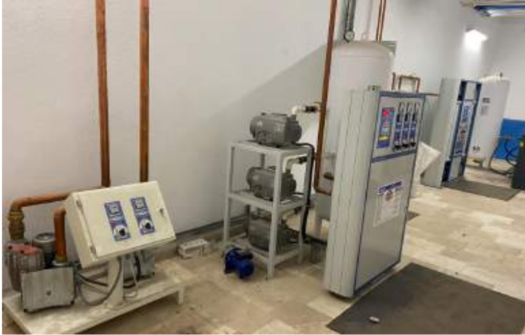
Resim 58. Vakum Pompaları
