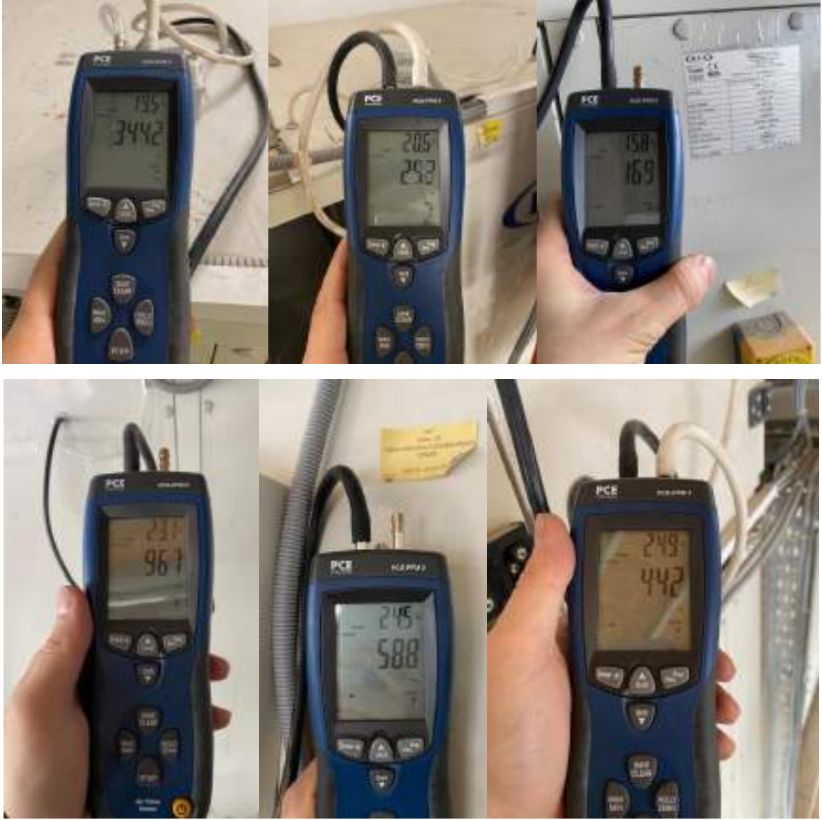
Resim 45. Havalandırma Sistemi Basınç Ölçümü
