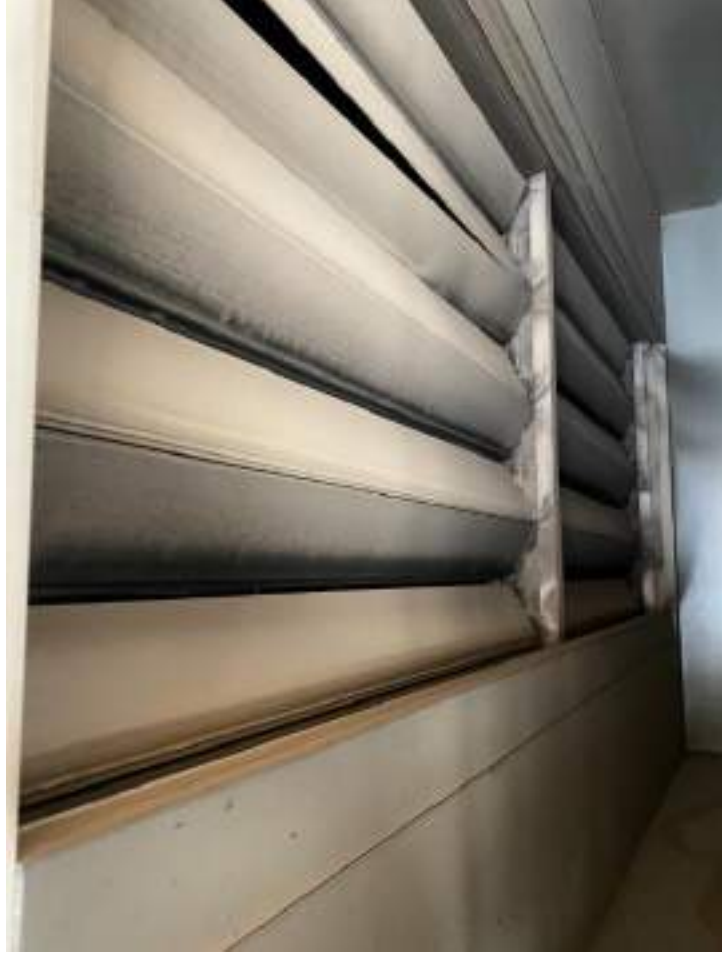
Resim 48. Aspiratör Emiş Tarafı Kapalı Damper
