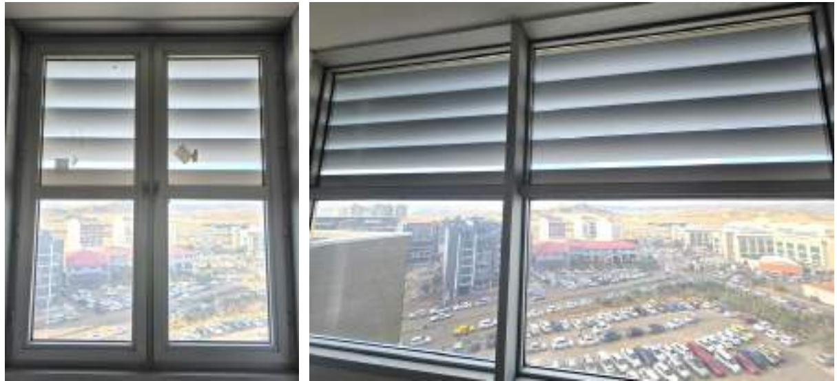
Resim 18. Bina Pencereleri Genel Görünüş
