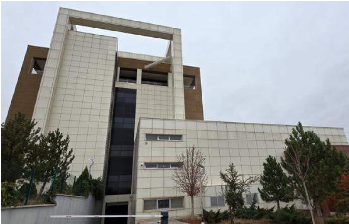
Resim 12. Kompozit Kaplamalı ve Cam Giydirme Cepheler
