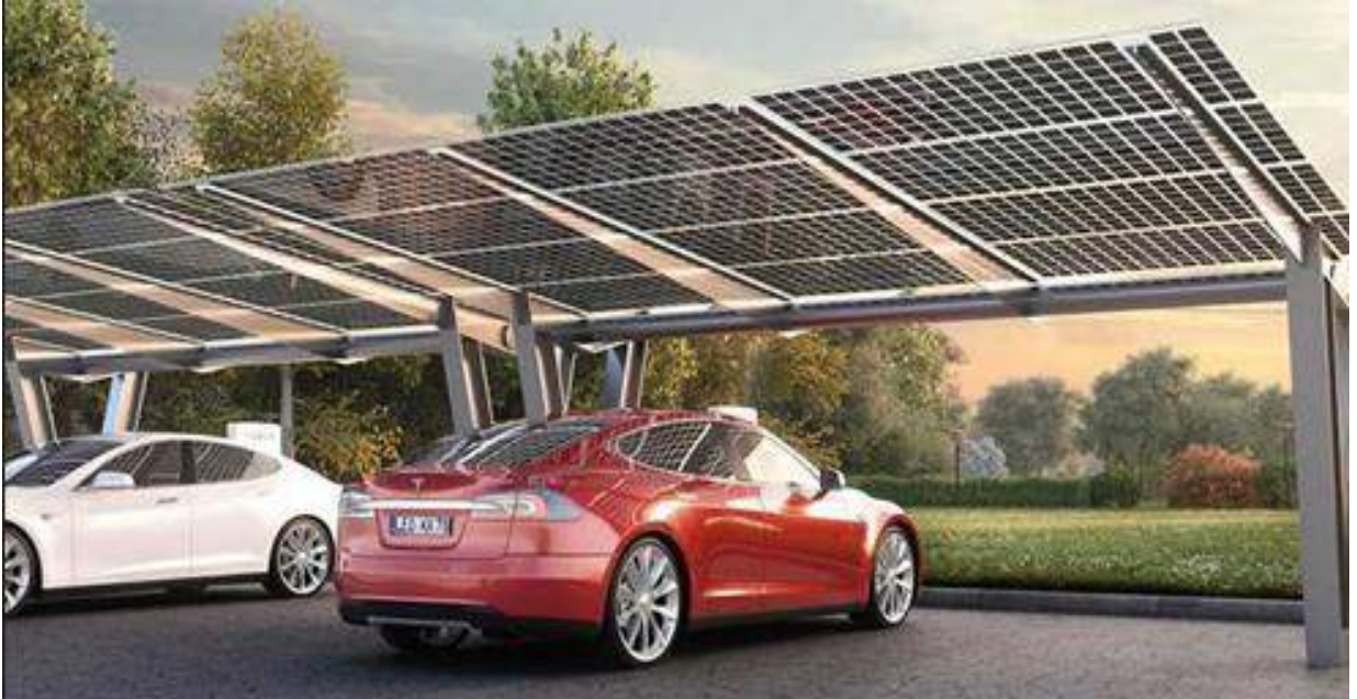
Resim 70. Otopark için “Carport” Tipi Panel Yerleşim Örneği
